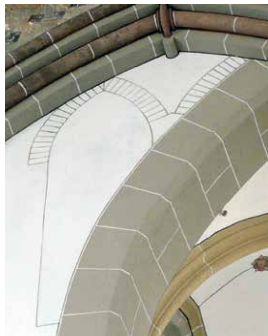
Oostzijde van het noordelijk transept met aangegeven waar voor 1370 de vensters waren.
