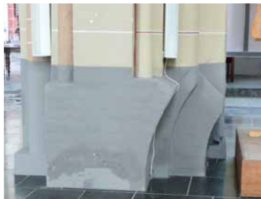
Restant van ingang tot de voormalige crypte, gezien vanuit huidige koor.
